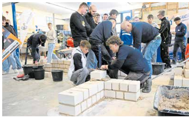
Hautnahe Einblicke in den Alltag eines Maurers gewährte die Firma Brandel Bau aus Tauberbischofsheim. Foto: Bianca Zäuner
