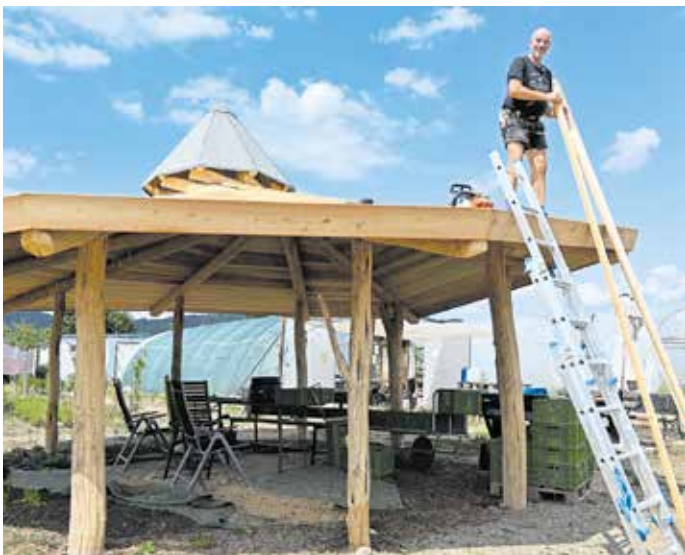
Tobias Heller errichtet auf dem Gelände der Solidarischen Landwirtschaft (Solawi) in Schwäbisch Hall-Wackershofen eine Überdachung für einen Freisitz.
